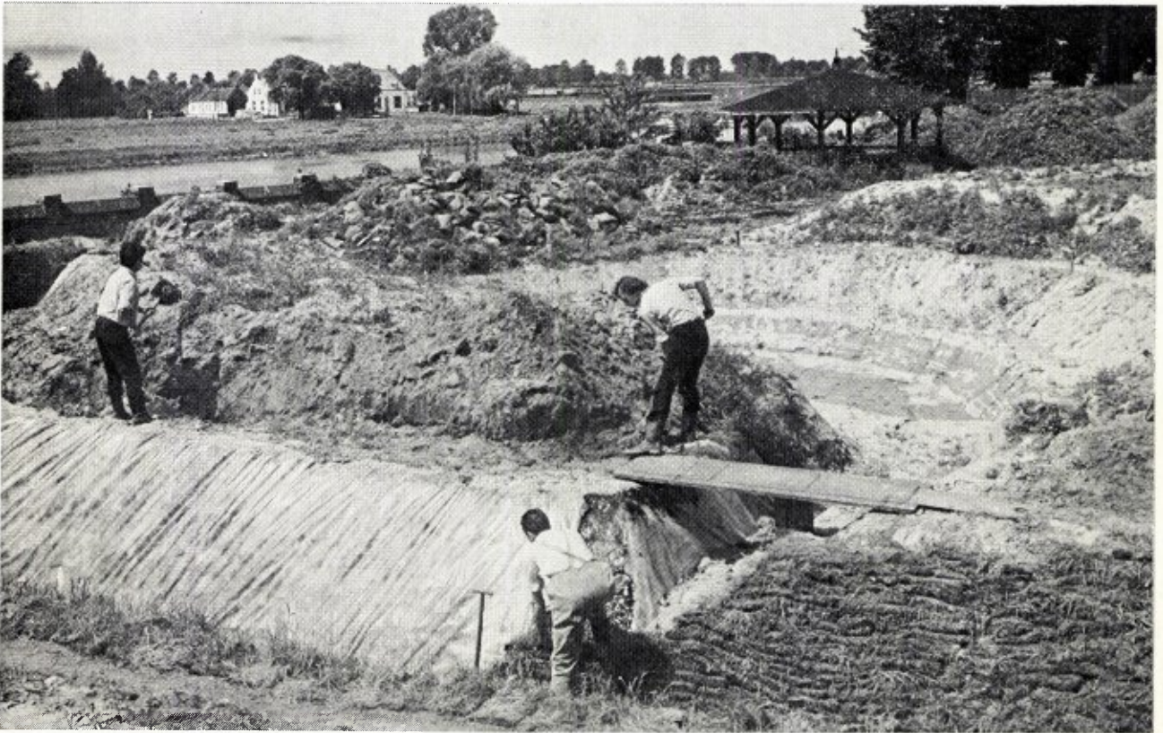
Grondwerkzaamheden tijdens de aanleg van de heemtuin; vooraan van links naar rechts de „miniatur-Maas” met daarachter (midden-rechts op de foto) het „Schuitwater”. (foto J. Lommen)
